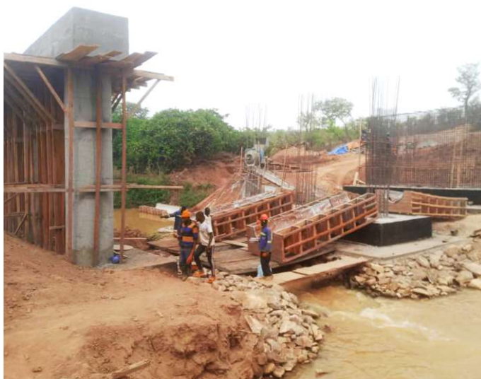
Travaux de construction d'un pont définitif de 37 mètres de long de portée sur la rivière Lom à Mbondo, Commune de Meiganga, Département du Mbéré, Région de l'Adamaoua.
