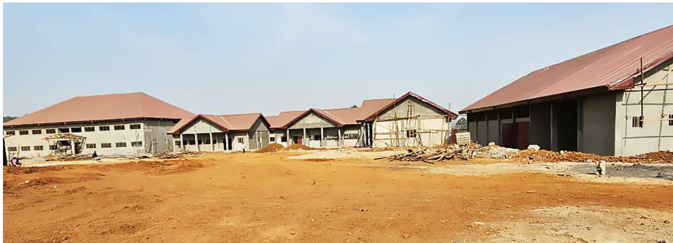
Chantier du Complexe du Lycée Technique de Nkambé ( Ndunga-Mantum) financé par le PROLOG
