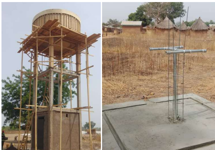
Construction d'une mini adduction d'eau potable dans la localité de WAFALA 1, Commune de Madingring, Département du Mayo Rey, Région du Nord.
