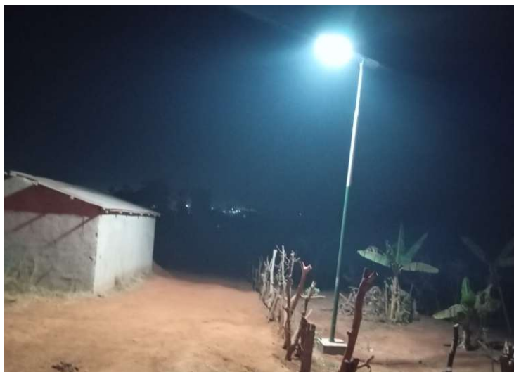
Travaux d'éclairage public par pose de 30 lampadaires solaires dans les artères de la ville de Ngaoundéré 2, Commune de Ngaoundéré 2, Région de l'Adamaoua.
