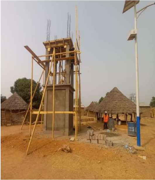
Travaux de réalisation d'une mini-adduction d'eau par captage de forage positif alimentée en énergie solaire à Mayo Baléo, Commune de Mayo Baléo, Département du Mayo-Banyo.
