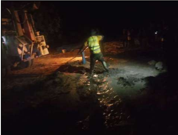
Travaux de construction d'une mini AEP à Gova dans la commune de Mogodé, Département du Mayo Tsanaga
