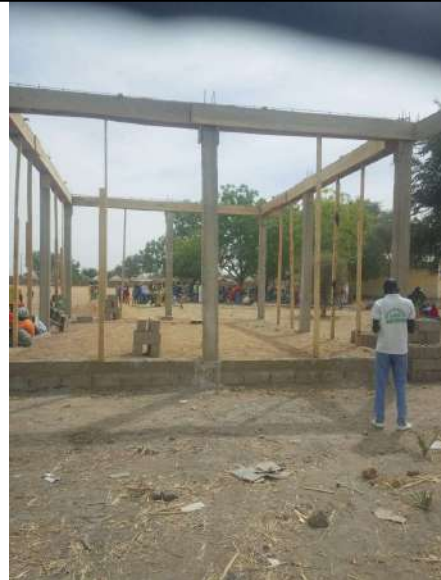
Travaux de construction d'un Hangar de marché à Dabaye, Commune de Guémé, Département du Mayo Danay
