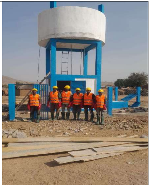
Travaux de construction d'une mini AEP à Bamguel, dans la commune de Hina, Département du Mayo Tsanaga
