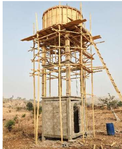
Travaux de construction d'un forage à énergie solaire dans la localité de NDOUZENG, Commune de Mayo-Oulo, Département du Mayo Louti, Région du Nord
