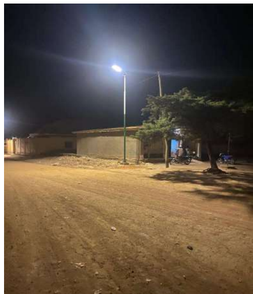
Travaux d'éclairage public par la pose des lampadaires solaires dans la ville de Ngaoui ainsi que les villages environnants Ngaoui, Bafouck, Alhamdou, Diel, Garga Pella, Djabori, Commune de Ngaoui.
