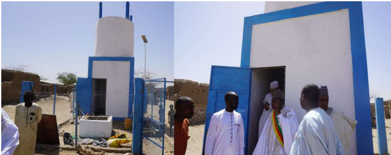
Travaux de construction d'une mini AEP à Blangafe, Commune de Fotokol, Département du Logone et Chari
