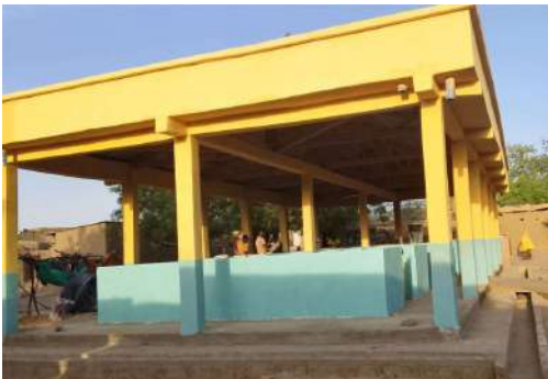
Travaux de construction Hangar marché de Glo Kotoko, Commune de Fotokol, Département du Logone et Chari
