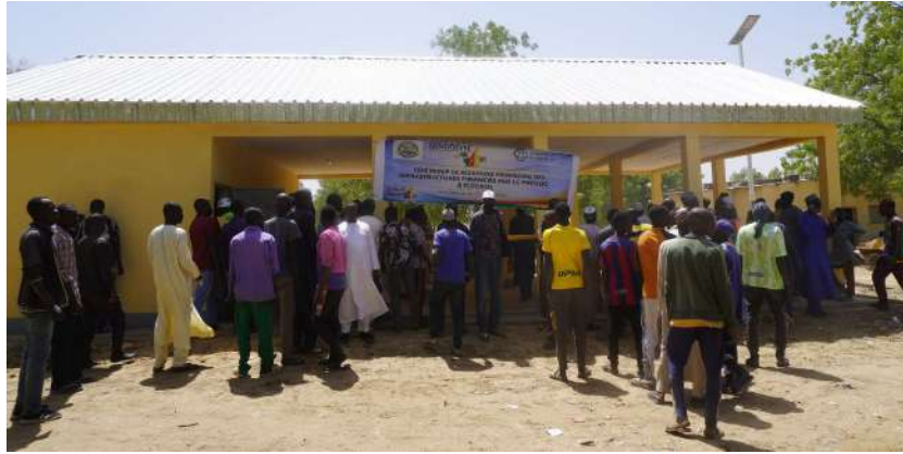
Travaux de construction d'une Gare routière à Gardoumba, Commune de Fotokol, Département du Logone et Chari
