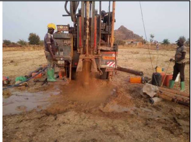
Travaux de construction d'une mini AEP à Ruffa dans la commune de Mogodé, Département du Mayo Tsanaga
