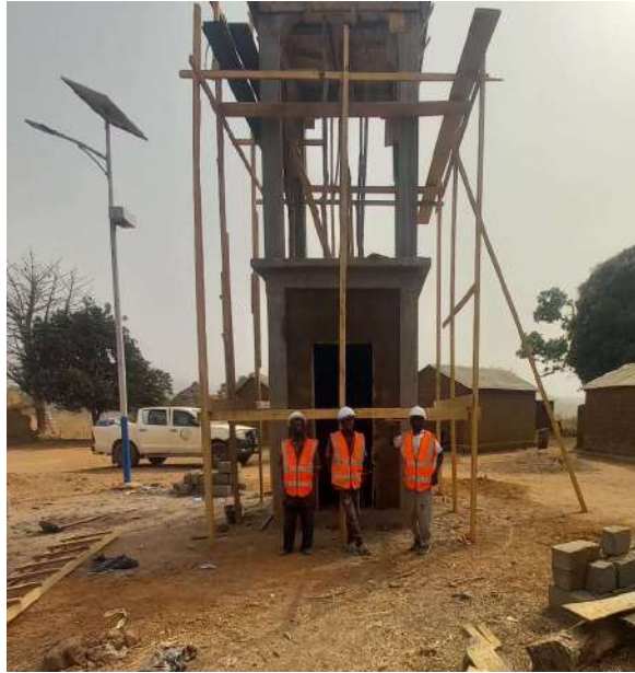
Travaux de réalisation d'une mini-adduction d'eau par captage de forage positif alimentée en énergie solaire à Mayo Baléo, Commune de Mayo Baléo, Département du Mayo-Banyo.
